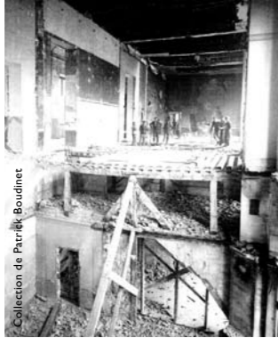
L'escalier d'honneur et le bureau du Maire après l'incendie de 1926
