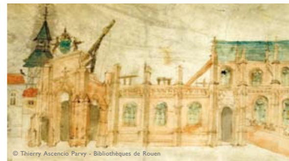
Le chantier de l'abbatiale en 1525 tiré du Livre des Fontaines de Jacques Le Lieur
