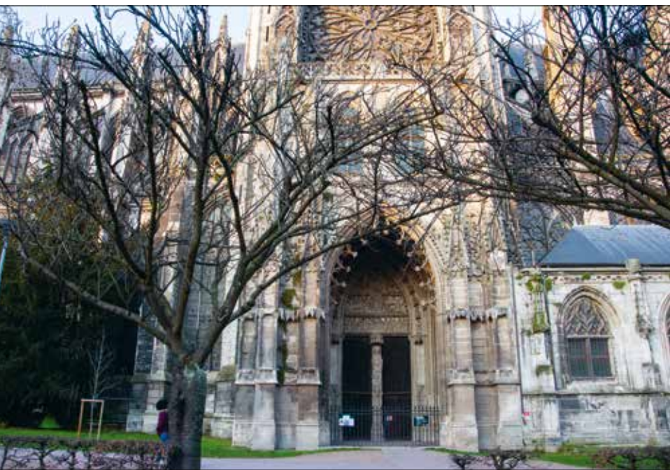
Au total, 20 millions d'euros seront déboursés par la Ville, la Métropole, la Région, le Département et l'État pour la rénovation de l'abbatiale Saint-Ouen.
