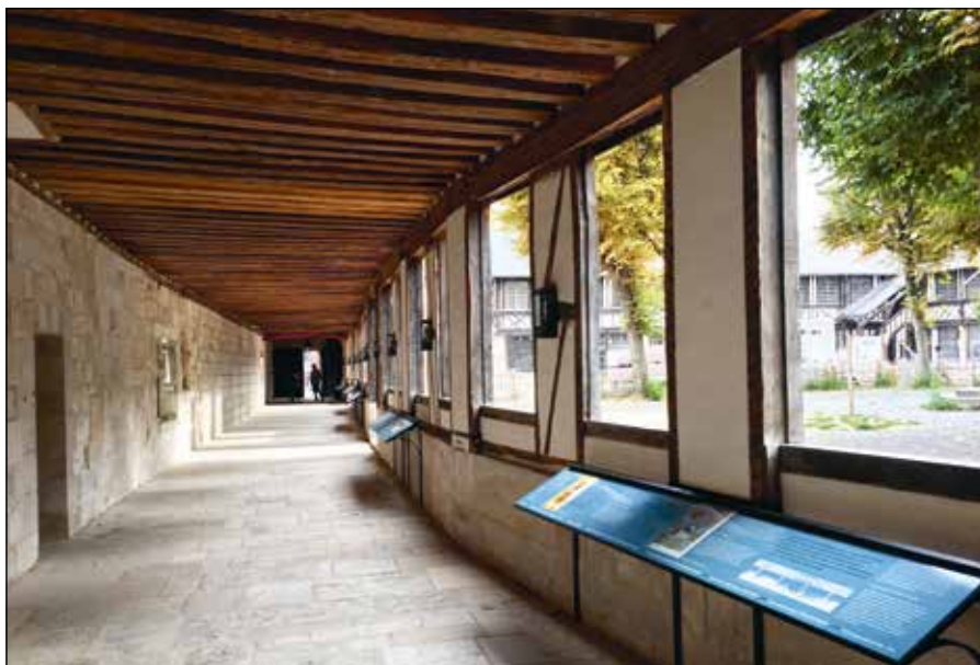
Le passage avec ses lutrins expliquant l'histoire du site et de sa restauration. Une statue et quelques inscriptions gravées dans la pierre ont également été mises en valeur.
