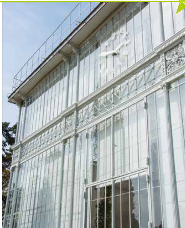
La serre à l'Horloge et son armature entièrement repeinte.
