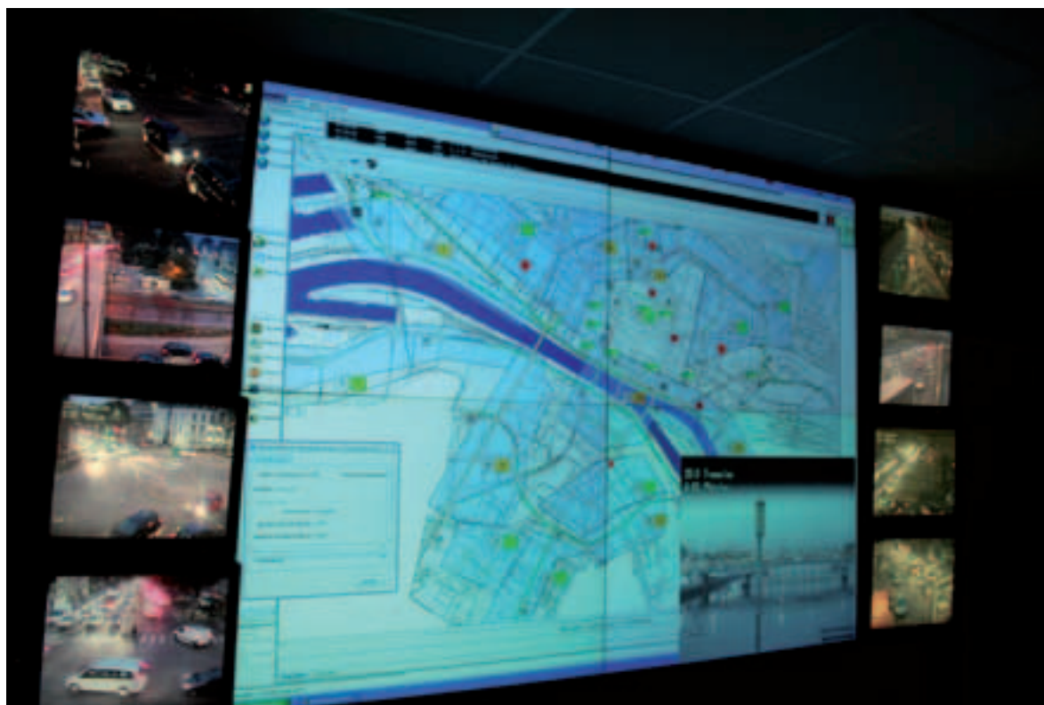
Au poste de contrôle de la sécurité, le trafic de Rouen et de son agglomération se suit en direct. De quoi anticiper et réguler la circulation.
