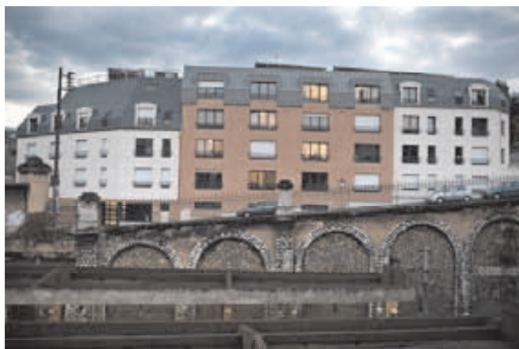
La surface moyenne des appartements atteint ici 25 m 2 , contre 17 habituellement.
