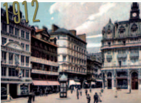
Au fond à droite, le siège social de la Mutuelle Vie. Le bâtiment, dont la construction avait duré 2 ans, de 1895 à 1897, a été détruit en 1972.
