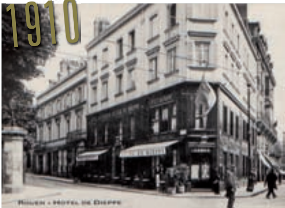
Face à la gare rue Verte, « l'hôtel-restaurant du chemin de fer de Dieppe ».
