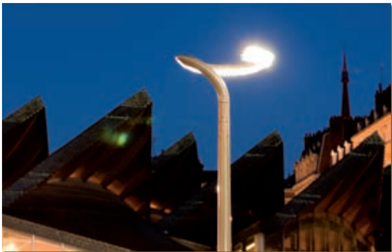
Tous les candélabres de la place du Vieux-Marché ont été remplacés.
