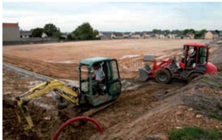
Le terrain a nécessité de nombreux aménagements pour être opérationnel.
