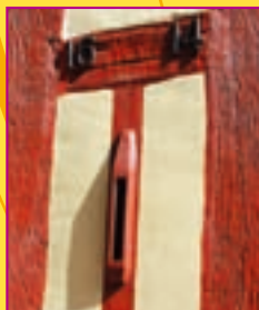
Réponse au n° 306 : détail de façade, rue Eau-de-Robec
