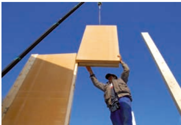
Le système Sanomur consiste à assembler des panneaux offrant une isolation optimale.
