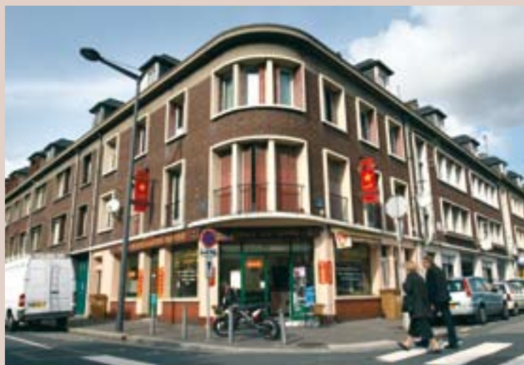
Usant de son droit de préemption, la Ville a acquis cet immeuble, avenue du Mont-Riboudet.
