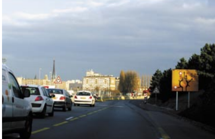
Les travaux visent à assurer l'accès au pont Gustave-Flaubert à partir de la voie rapide.
