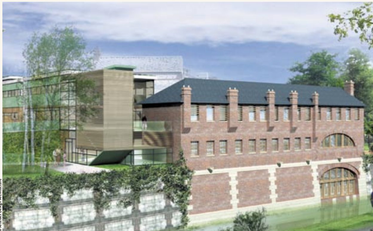
Vue de la façade arrière, depuis la rue des Petites-Eaux-du-Robec.
