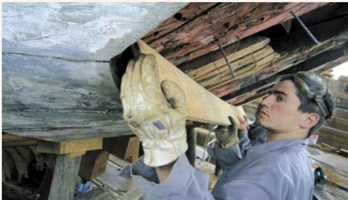
Plusieurs élèves et anciens élèves du lycée Edmond-Doucet travaillent sur le chantier de restauration.
