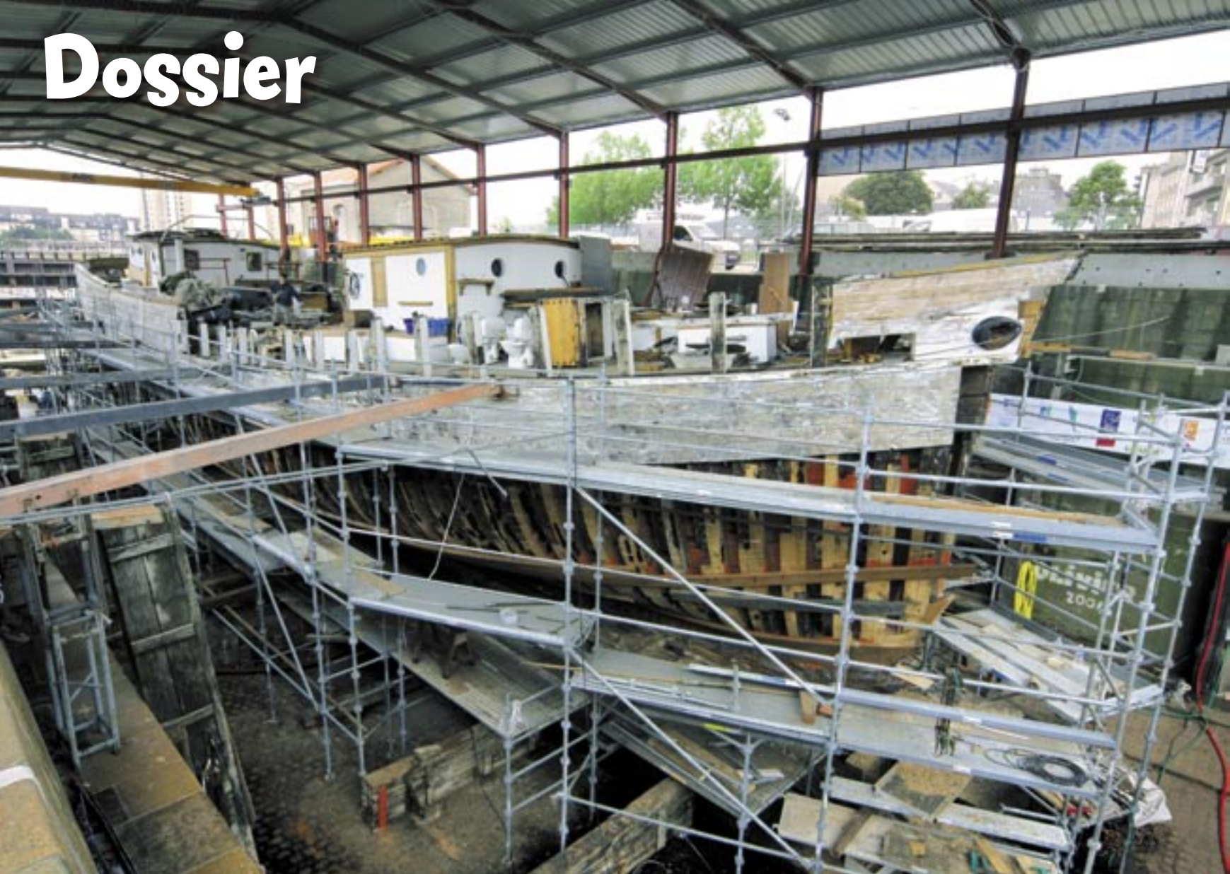
La totalité des membrures basses du Marité ont été remplacées. Toute la partie supérieure de la coque doit encore être restaurée.
