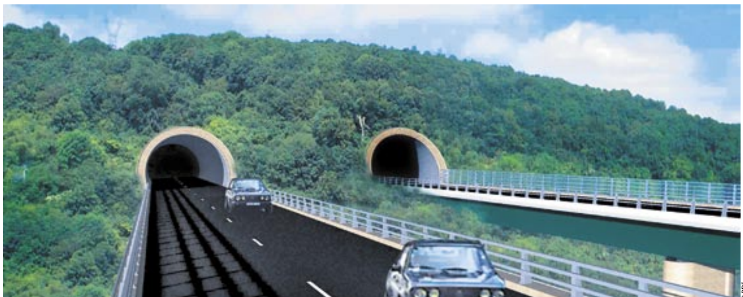
Sous la commune de Belbeuf, chacun des deux tunnels offrira deux voies de circulation.
