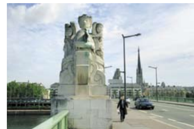
Dans le but de diminuer davantage la circulation en centre-ville, le pont Boieldieu deviendra semi-piéton en 2007. Les trottoirs seront élargis. Une piste cyclable sera créée, réduisant à deux les voies routières du pont.
