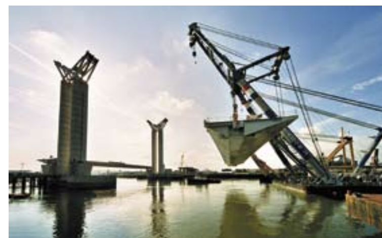
22 août : Taklift et Matador 3 avancent progressivement pour déposer la seconde travée.
