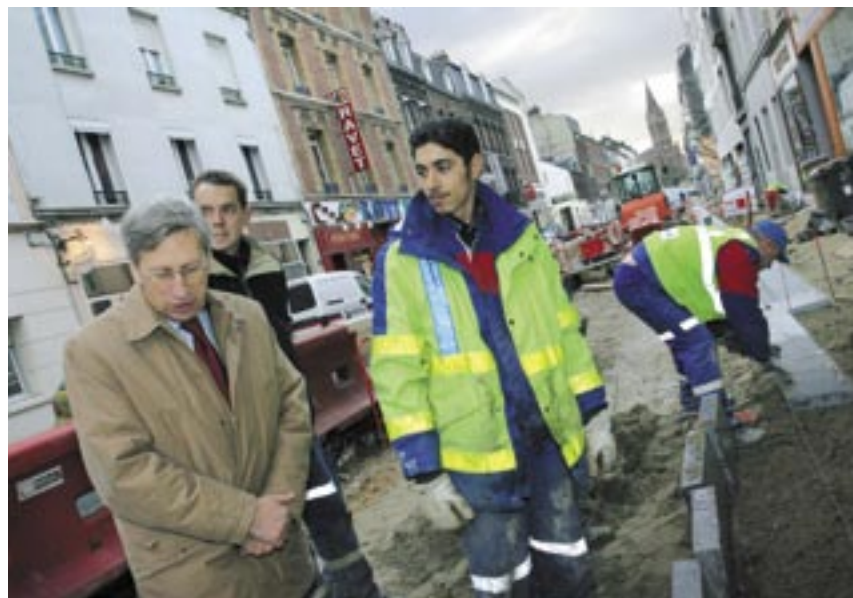
Pierre Albertini, visitant le chantier début décembre, s'est félicité de l'avancement des travaux.
