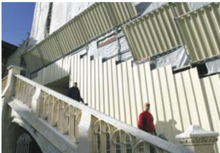
L'escalier menant à la Salle des procureurs est pour l'instant le seul élément visible.
