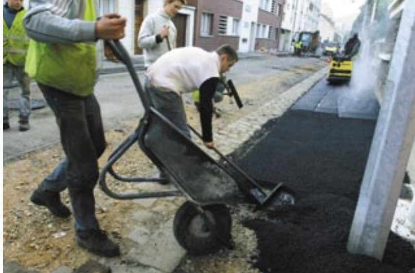
La rue Stanislas-Girardin a bénéficié du programme de restauration de la voirie.
