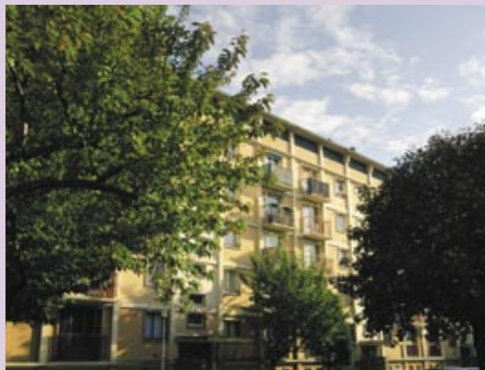
621 logements sociaux seront réhabilités dans la résidence Marin-le-Pigny.
