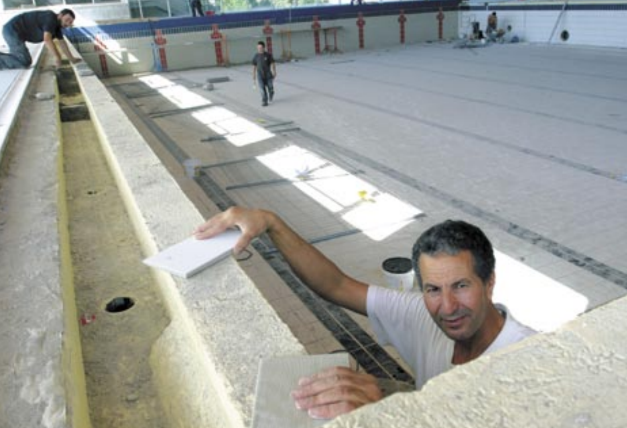
Après le bassin extérieur, les équipements intérieurs de la piscine Boissière font eux aussi peau neuve.
