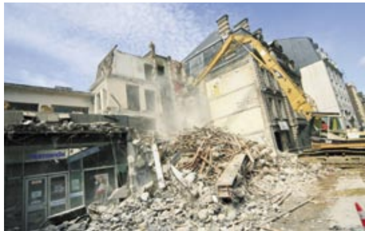
Le chantier des Terrasses Saint-Ouen est prévu pour durer deux ans.
