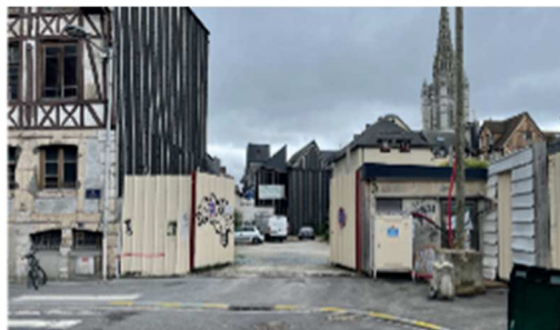
photo de l'existant avec l'ancien transformateur
