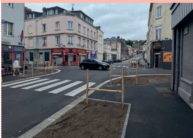
La deuxième partie des travaux, qui ont eu lieu cet été, ont notamment concerné le carrefour des rues de Constantine et du Pré de la Bataille.
