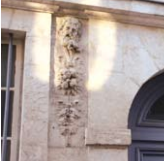
Détail de façade du 29, rue des Requis
